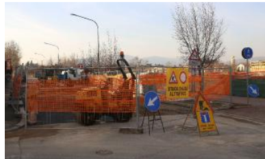
Dopo la rottura del tubo dell'acqua la strada è stata chiusa FOTOLIVE
