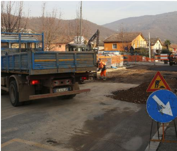
Il cantiere di via Montini aperto per rimettere in sicurezza l'area dove c'è stato l'allagamento FOTOLIVE
