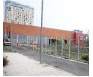
Rimossi i più danneggiati
