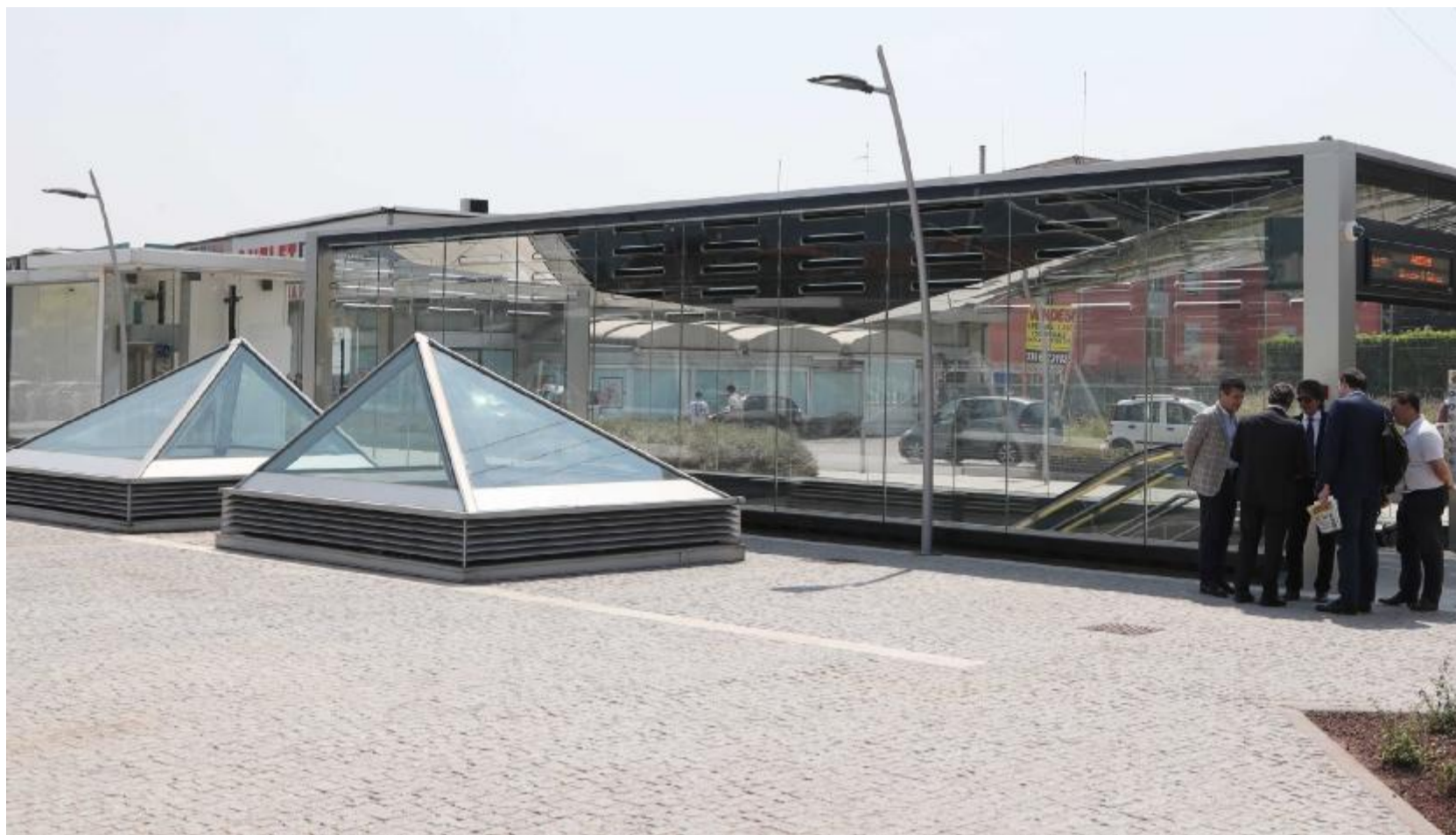
Una veduta d'insieme delle nuove pensiline che coprono le scale di accesso alla stazione Prealpino, capolinea Nord della metropolitana leggera di Brescia. FOTOLIVE/Simone Venezia
