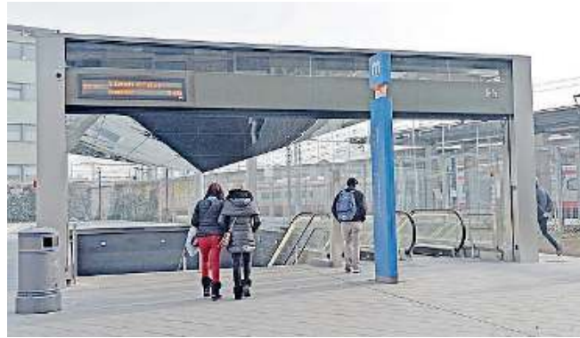
La tettoia. La nuova copertura all'ingresso della stazione Fs della metro
