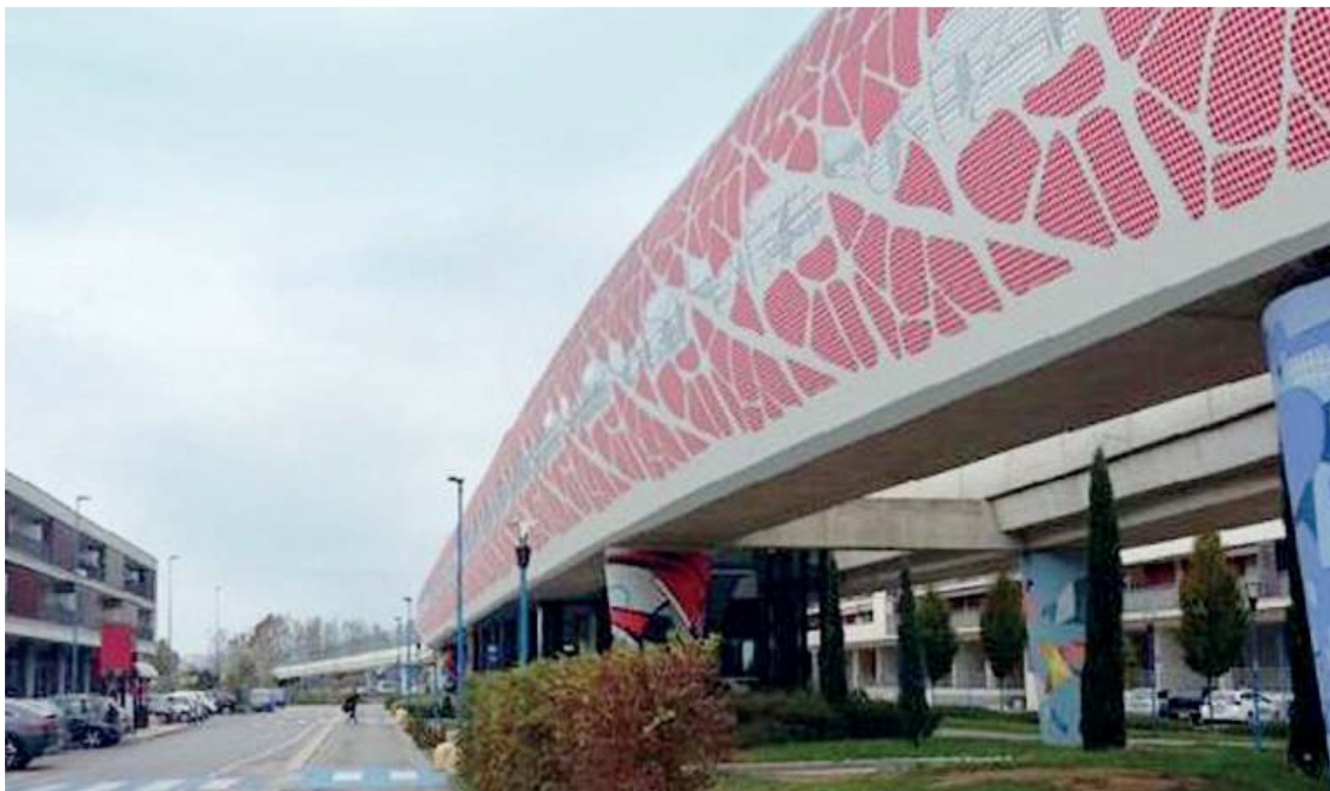
Come sarà. A breve inizieranno i lavori per posizionare le nuove barriere fonoassorbenti lungo la metropolitana in zona Sanpolino
