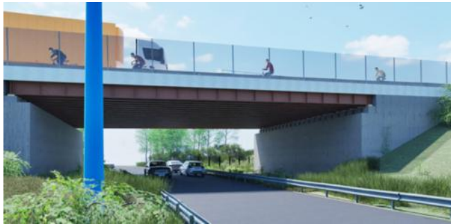
Un'immagine il ponte di via Labirinto che sovrasta via Cozzaglio nella zona sud di Brescia
