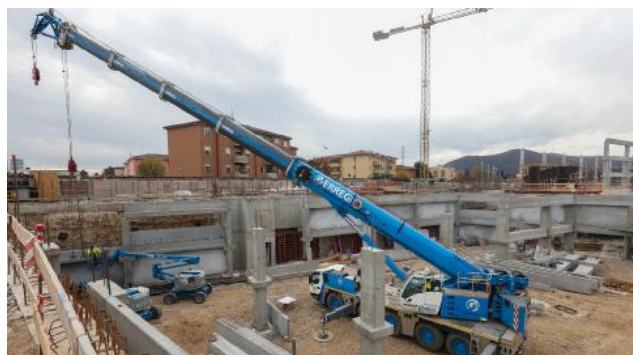
Senza ritardi Una enorme autogrù in azione nel cantiere del grande parcheggio ONLYCREW
