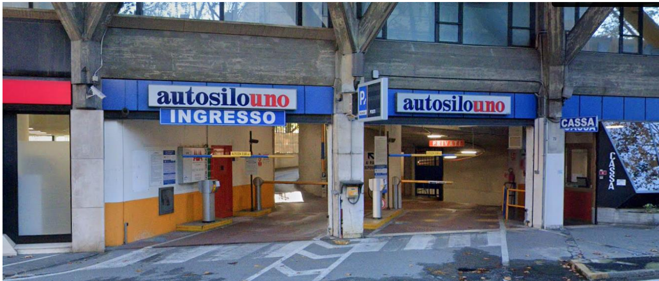
** Ingresso dell'autorimessa Autosilo 1.
