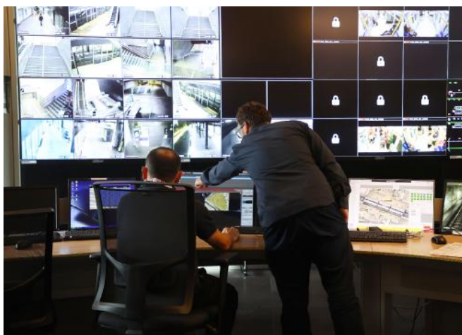
Tutto ciò che accade visibile in tempo reale sul videowall della sala controllo ONLY CREW
