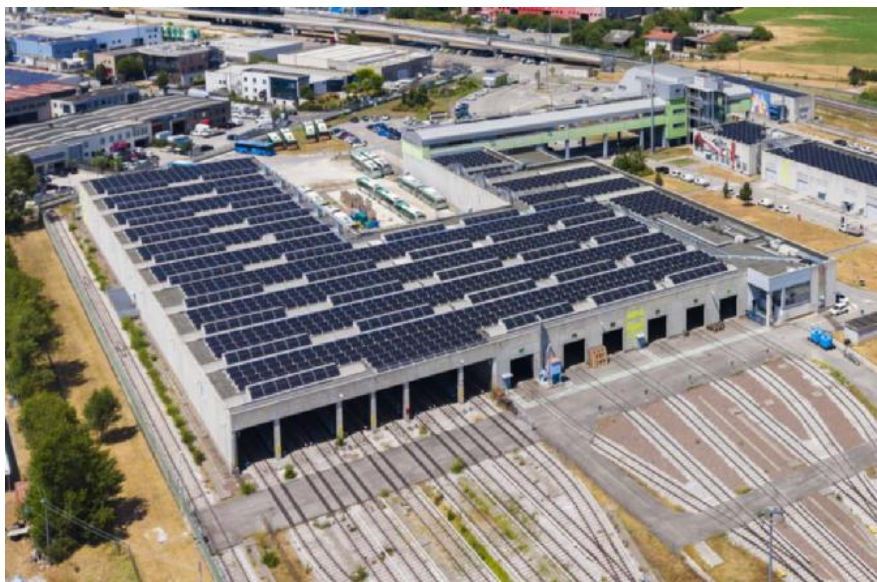
I pannelli sono distribuiti tra le coperture dell'officina, della rimessa, del deposito, del lavaggio e dei locali tecnici
