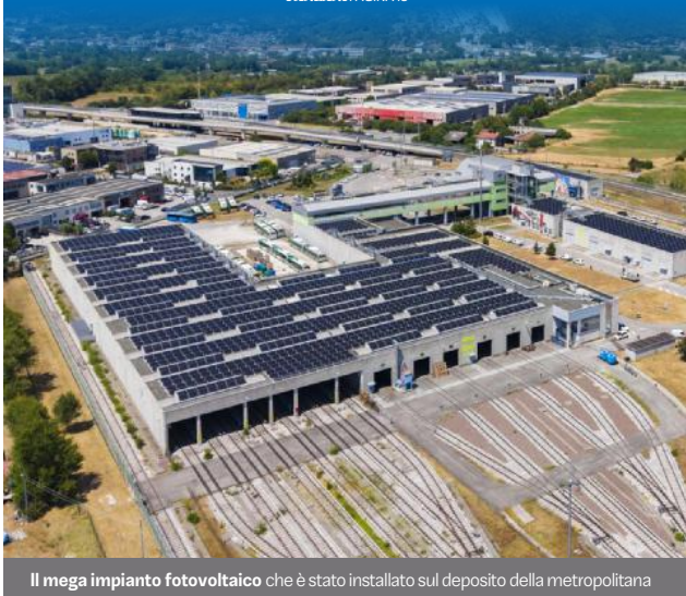
Il mega impianto fotovoltaico che è stato installato sul deposito della metropolitana
