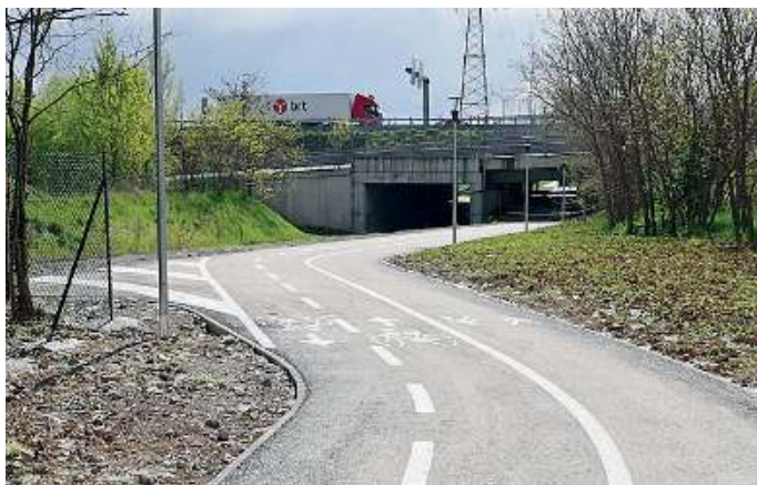
Il sottopasso. Da via Girelli al tunnel sotto l'autostrada A4
