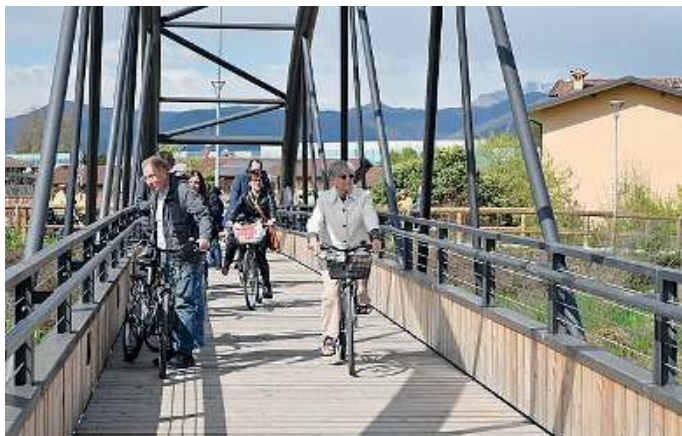
Ponte. Nel percorso ciclopeditonale di collegamento // FOTO STRADA (NEG)
