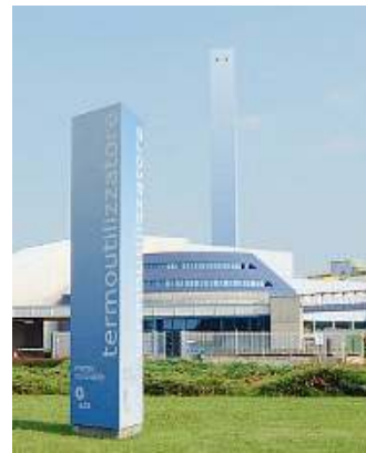
Termoutilizzatore. Produce il 70% del calore del teleriscaldamento
