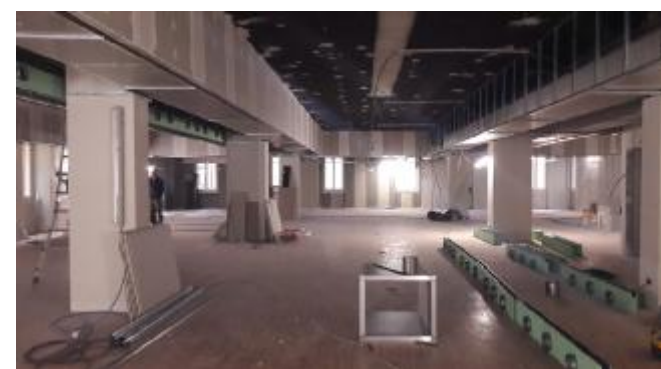
Una fase della posa dell'impianto di ventilazione al secondo piano
