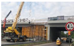
L'intervento Procede la ricostruzione
