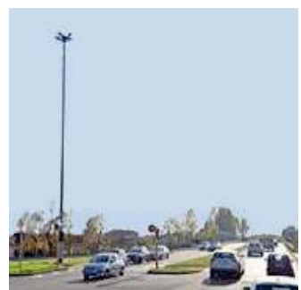
Lavori in vista. Qui sorgerà una rotonda
