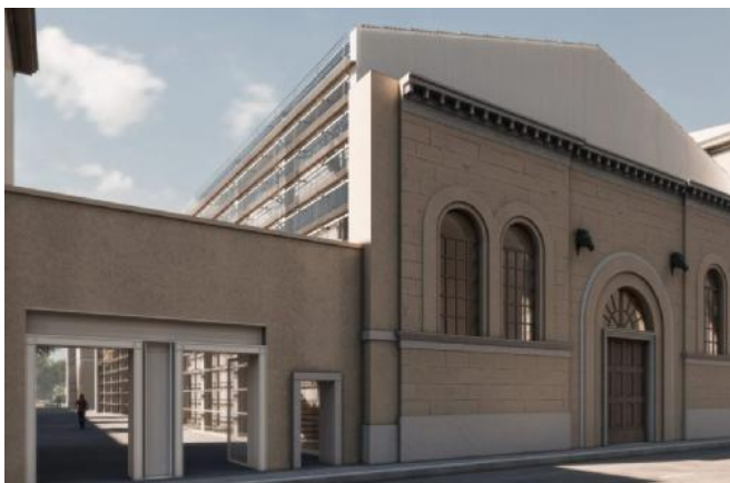
L'esterno La facciata su via delle Grazie e dietro il nuovo edificio trasparente
