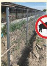
per impedire il passaggio dei cinghiali, realizzata in PANNELLI RIGIDI può essere installata direttamente nel terreno oppure al suolo.
