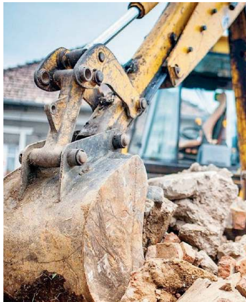
In stand-by. Tanti i bandi e i cantieri rimasti impigliati nel caro materiali
