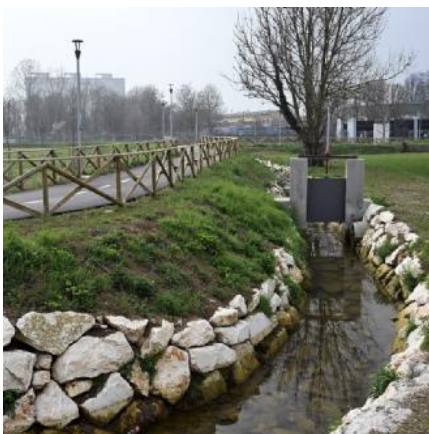
L'area di San Polo Parco messa in sicurezza
