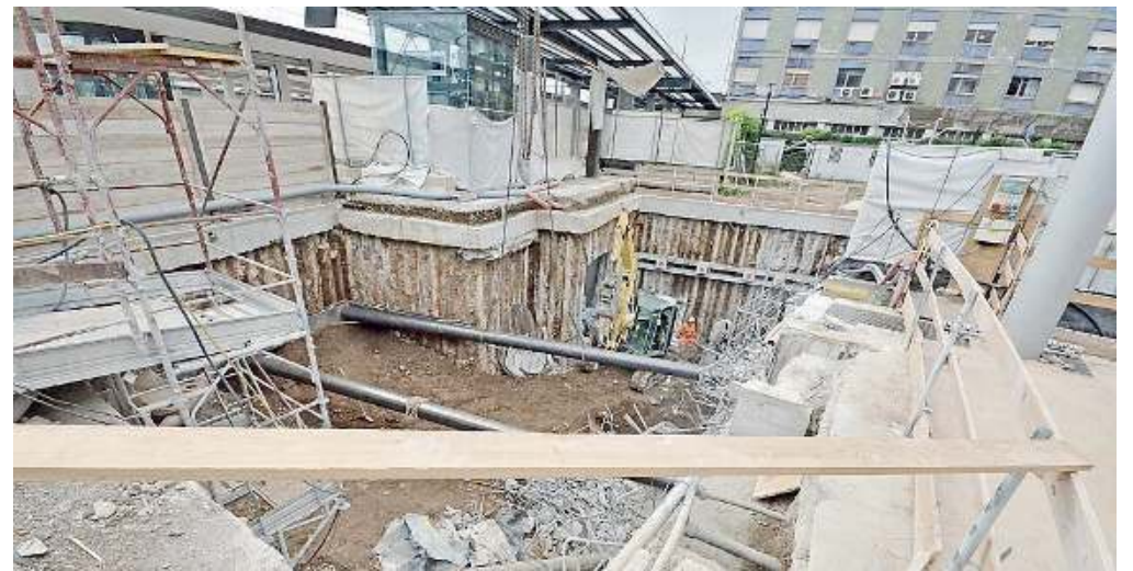
Cantiere. L'area tra il sottopasso Tav e la stazione metro dove saranno realizzate le scale di raccordo // NEG PUTELLI
