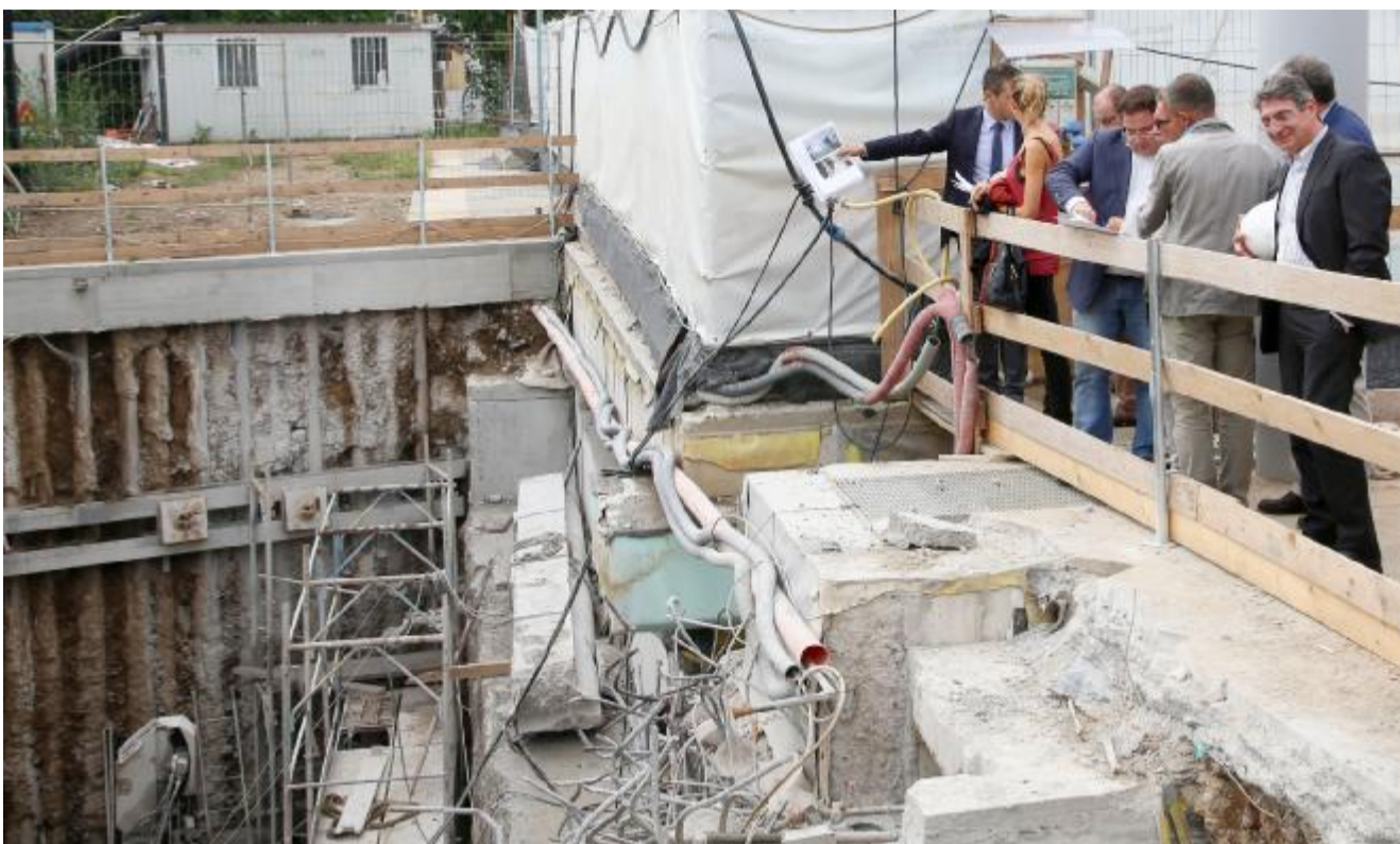
Il sindaco Emilio Del Bono e le altre autorità durante il sopralluogo al cantiere del tunnel di collegamento tra metro e stazione FOTOLIVE
