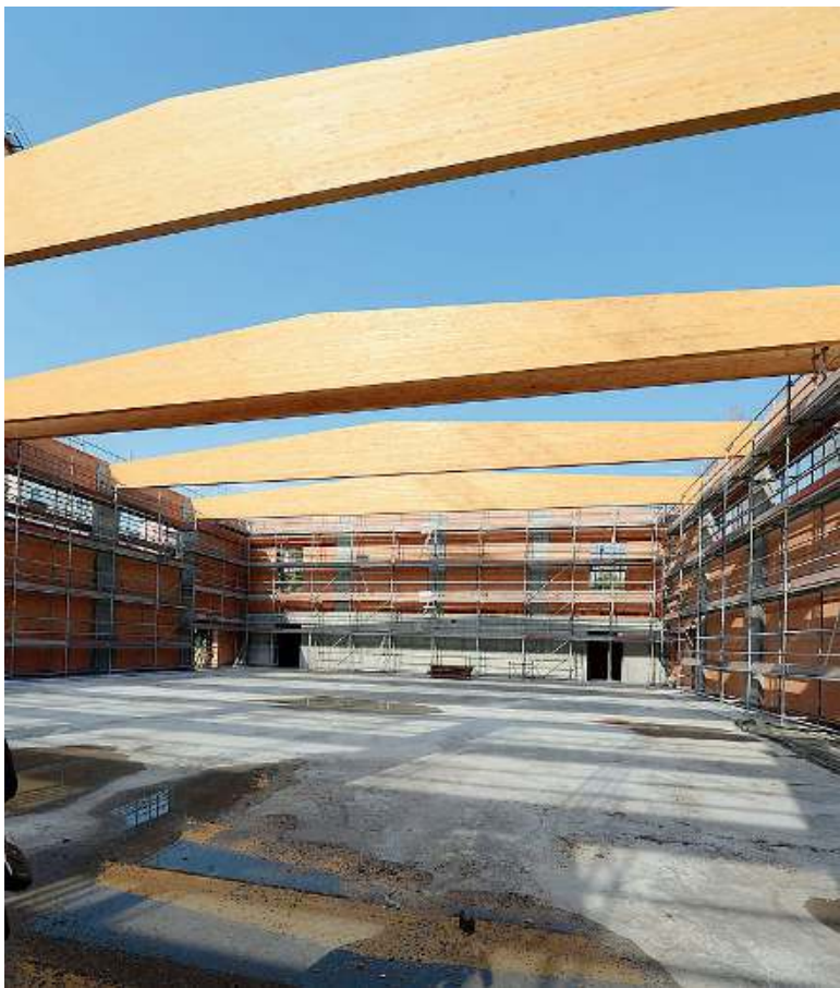
La palestra. L'interno del nuovo impianto con le travi lamellari del futuro tetto
