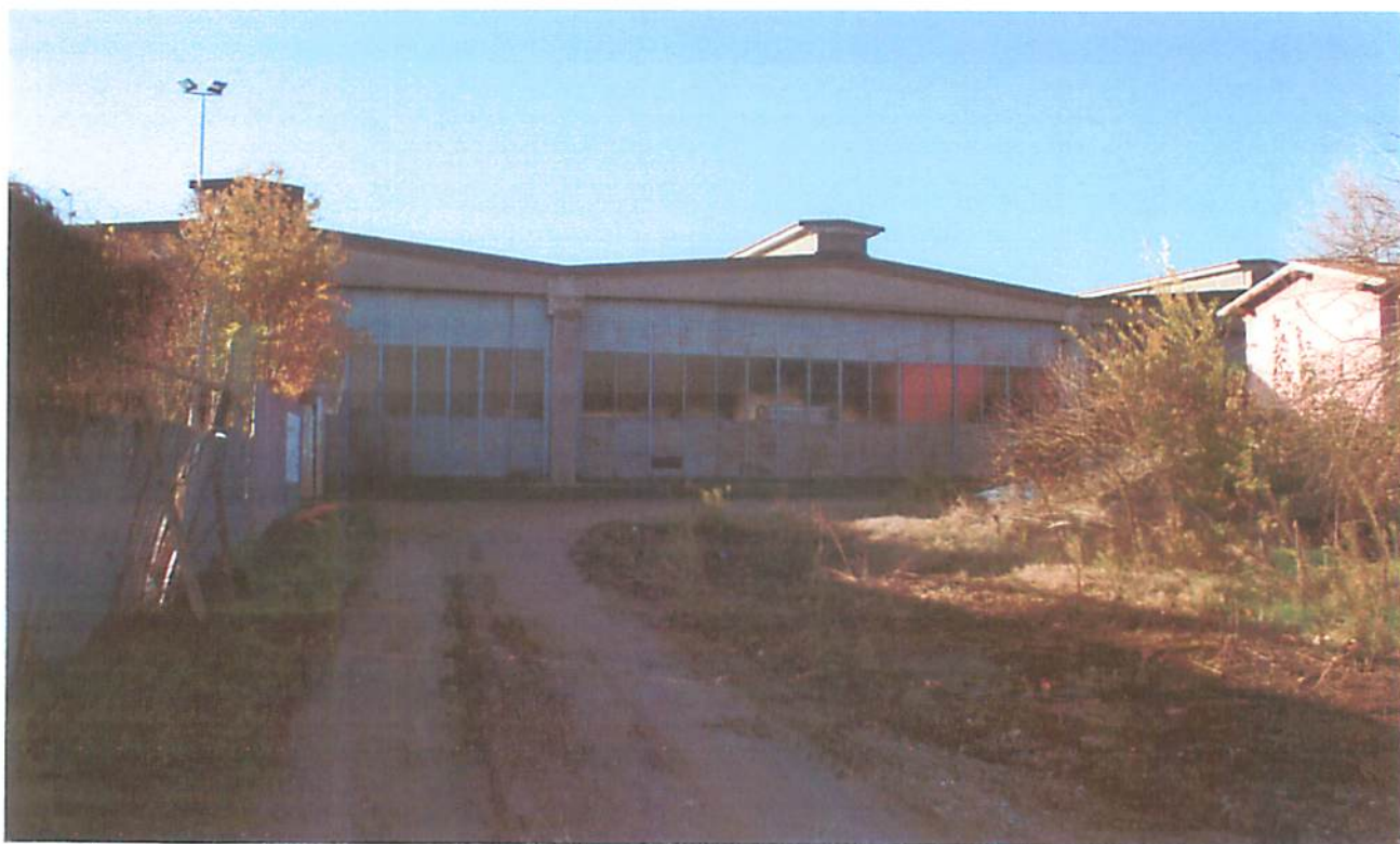
3 ↑ Recinzione cantiere Metropolitana ↑ Via Romiglia
