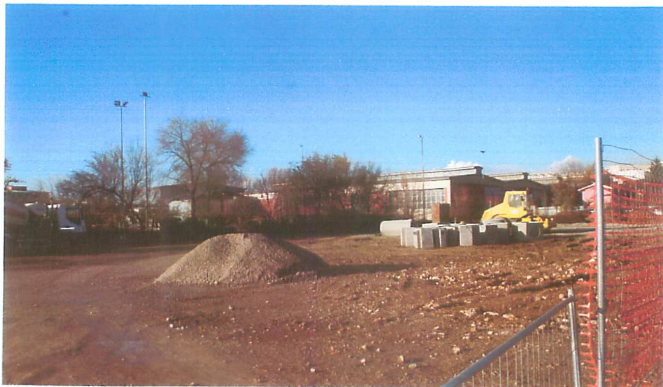
4 ↑ Cantiere Metropolitana ↑ Vista area da Est
